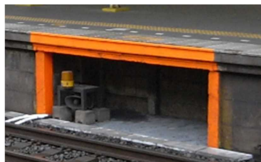
ホーム下の待避スペース
