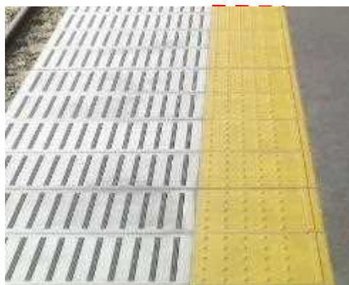
内方線付き点状ブロック
