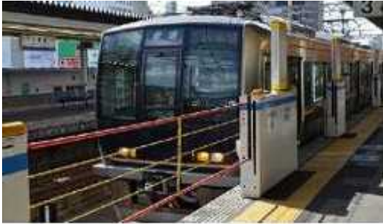
昇降ロープ式ホーム柵
