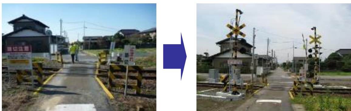
図31：遮断機・警報機の整備
