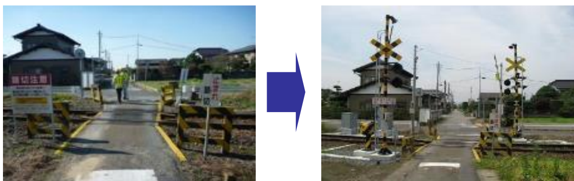
図31：踏切遮断機・踏切警報機の整備
