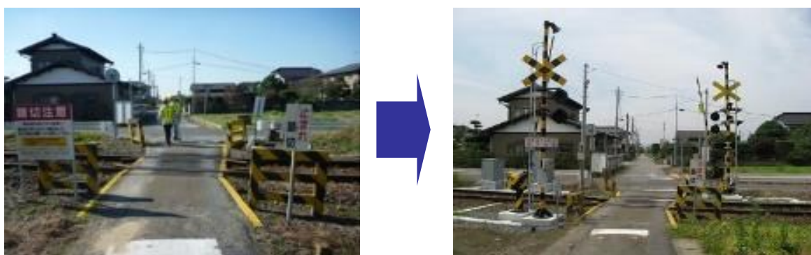
図31：踏切遮断機・踏切警報機の整備
