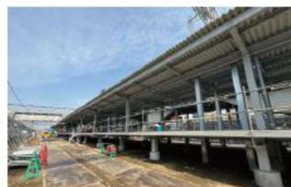
【春日部駅付近連続立体交差事業】
