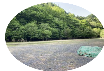
▲藤島発生土置き場
