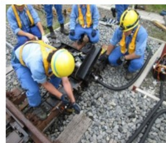
電気設備整備 （転てつ機点検作業）
