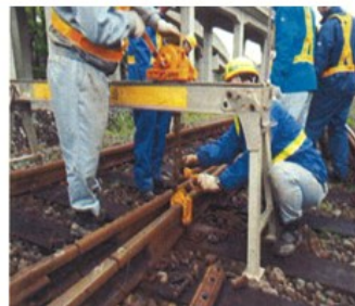
軌道整備 （レール交換作業）
