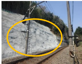
コンクリート法面
