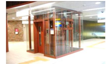
エレベーター
