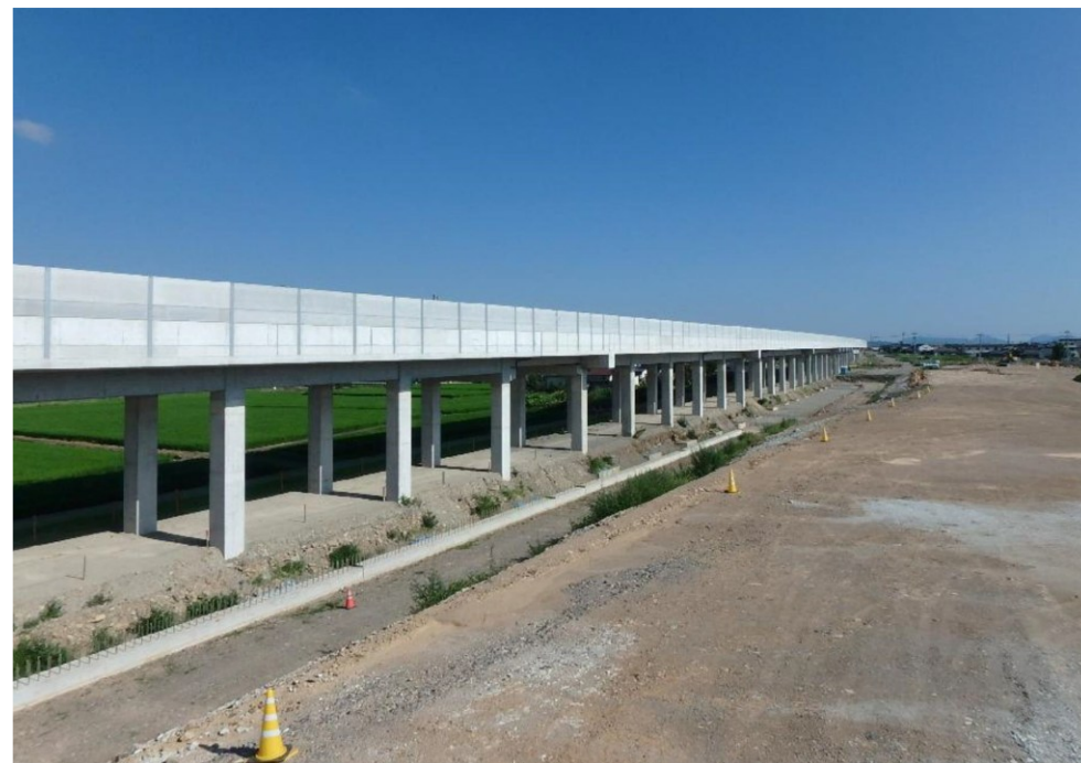
竹松高架橋他工区
