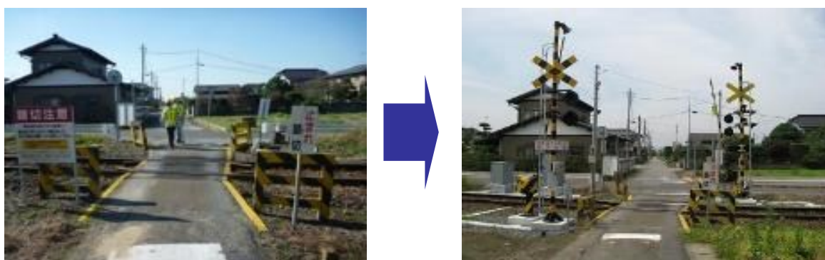
図31：踏切遮断機・踏切警報機の整備
