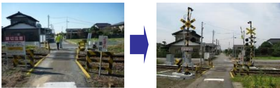
図31：踏切遮断機・踏切警報機の整備
