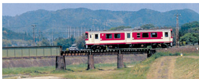
橋梁の変状、錆、劣化等
