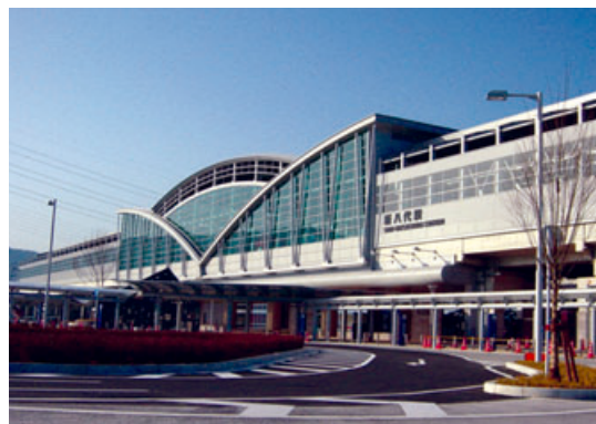
▼九州新幹線新八代駅外観
