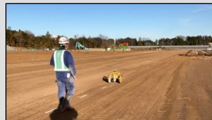
マーキング作業状況
