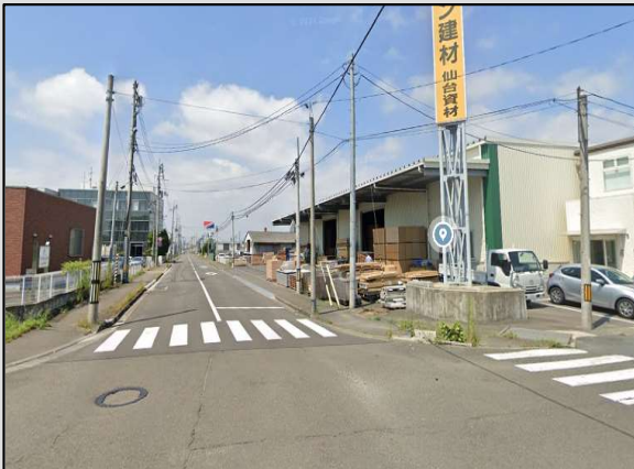
着手前の架空線状況
