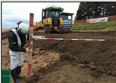
従来方法での巻き出し厚さ確認時の状況
