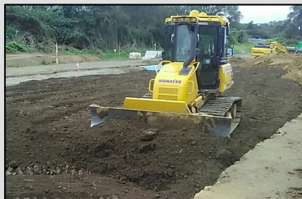
マシンコントロール搭載建機での敷均し状況
