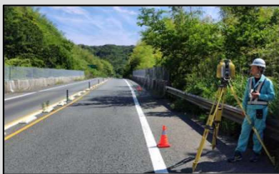
3Dレーザースキャナーでの測量状況
