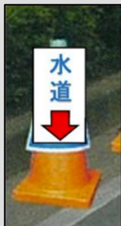
写真1 従前の埋設物の 見える化方法
