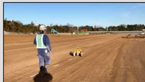
マーキング作業状況
