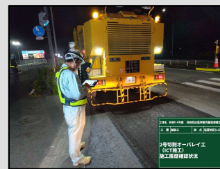
ICT建機での施工状況
