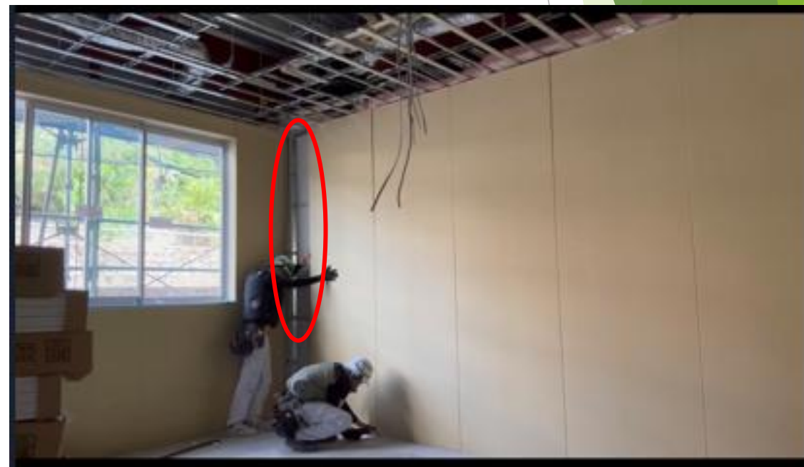
赤線のように、規格以外の大きさの箇所をカットする必要がある
