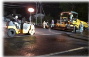
通行不能の交差点での応急工事
