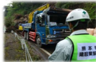
道路啓開(倒木・土砂の撤去)
