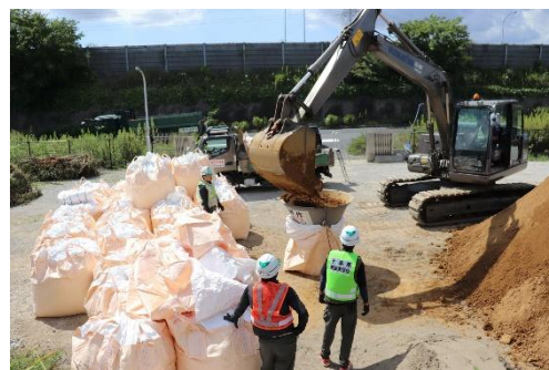
土のう作製状況 (千葉市緑区)
