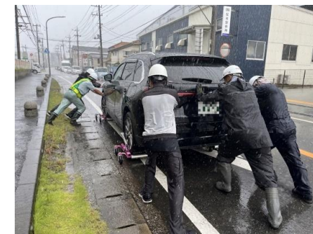
道路啓開作業 (放置車両撤去)
