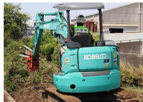
重機を使用した 道路啓開作業 (千葉市緑区)
