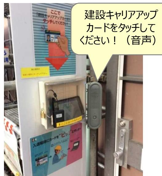
人感センサーによるスピーカーを設置して、技能者に自動呼びかけ
