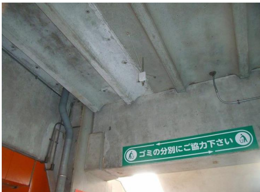
図 4.2-4 BLE ビーコン設置例(日産スタジアム ワイヤーでの設置)
