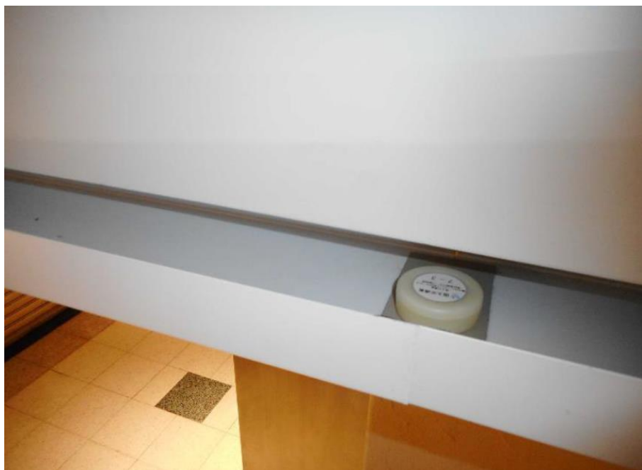
図 4.2-3 BLE ビーコン設置例(新宿サブナード 既存の構造物の上面への設置)
