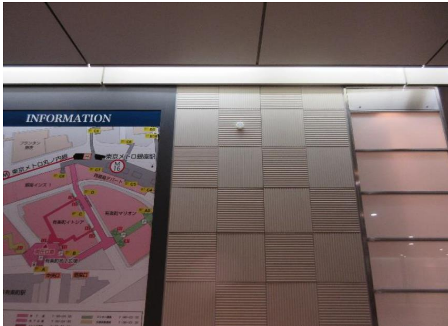
図 4.2-2 BLE ビーコン設置例(有楽町駅地下 接着剤を利用した壁面への設置)
