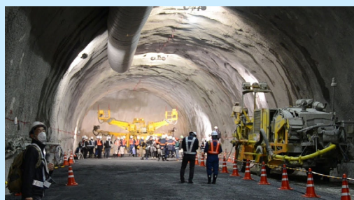
屋内作業現場の把握・効率化
