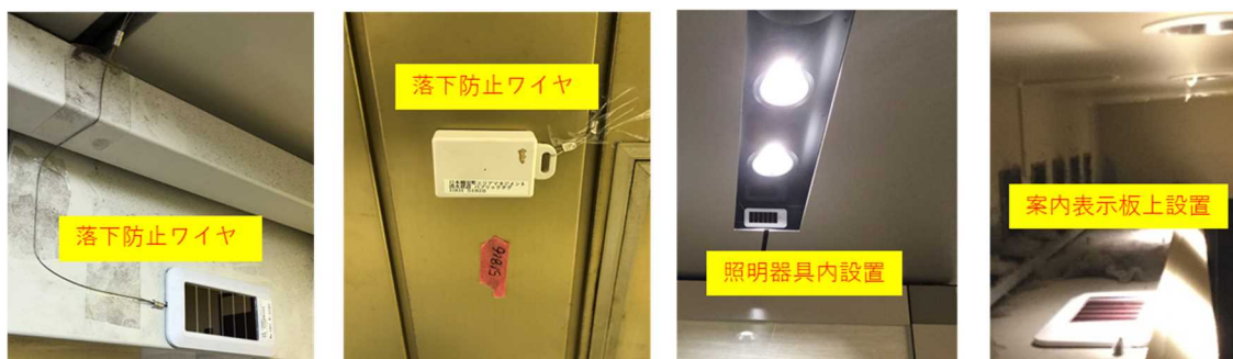
図 14. ビーコン設置状況
