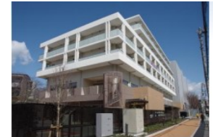
コーシャハイム向原7号棟 (サービス付き高齢者向け住宅)
