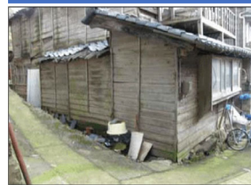
【解体撤去前】 延べ床面積約120㎡
