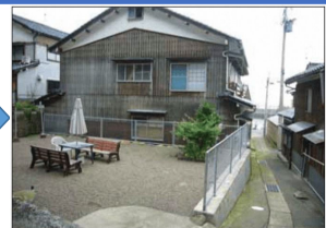
【解体後】跡地(約150㎡)に ポケットパークを整備
