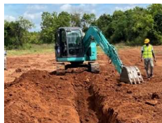
油圧ショベルの実技講習の様子
