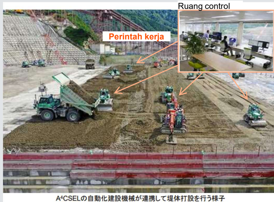
A4CSELの自動化建設機械が連携して堤体打設を行う様子
