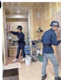
内装工事作業の様子
