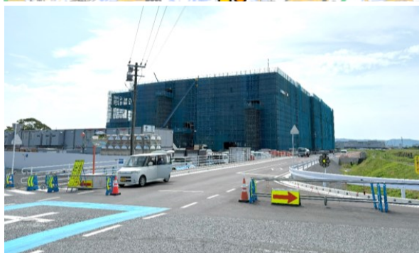
佐賀県基山町（大型物流施設建設中）
