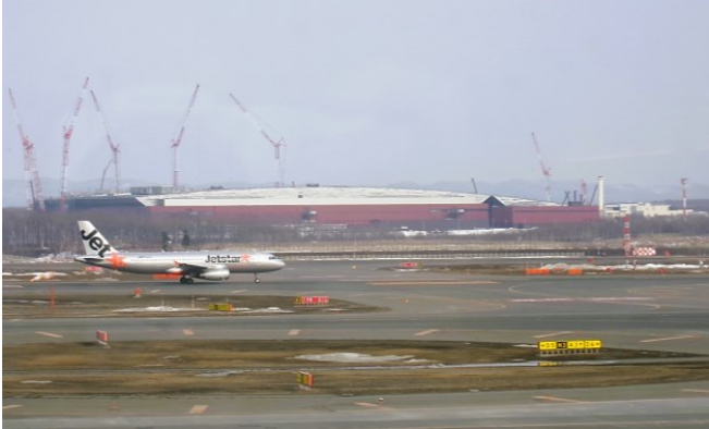
北海道千歳市「最先端半導体製造施設」
