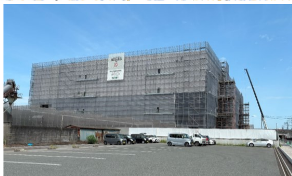
佐賀県鳥栖市（大型物流施設建設中）
