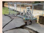
水道の復旧 (被災した浄水場)
