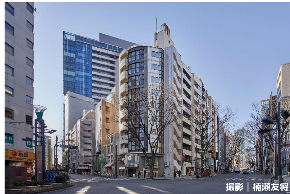
▲改修後の外観
