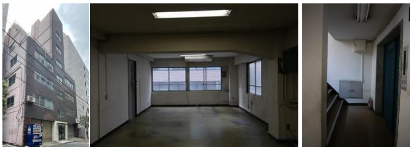
△改修前の状態
