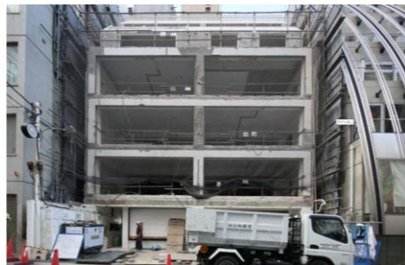
施工中（バルコニー・スラブ一部解体）
