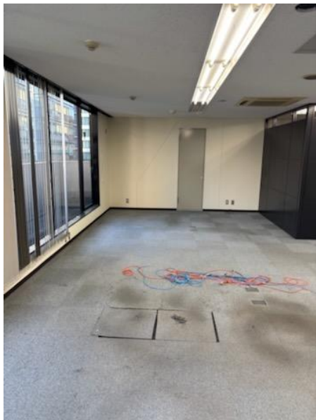
▲改修前の執務室
