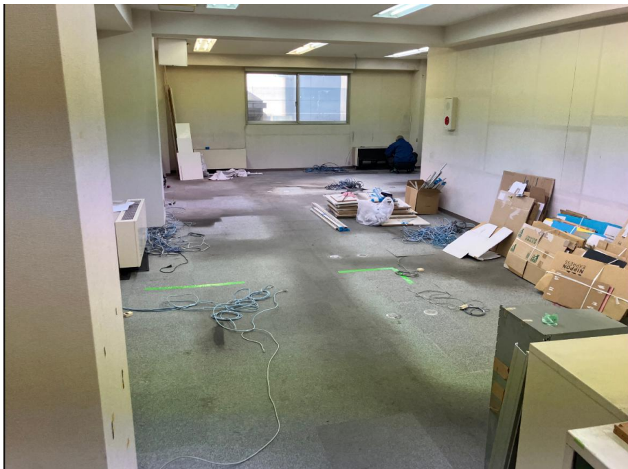
▲改修前の執務室
