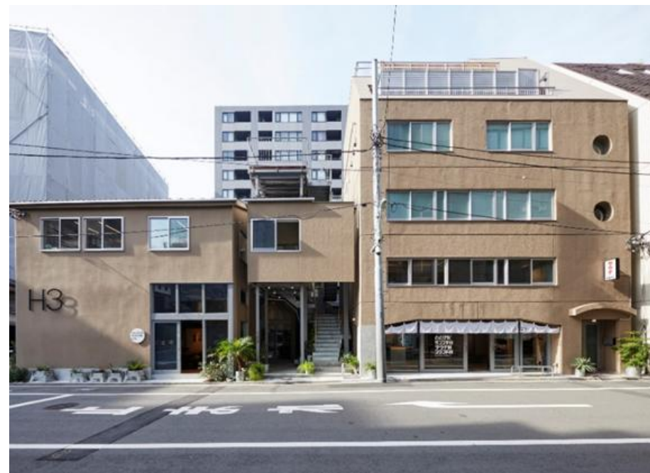
▲改修後の外観
