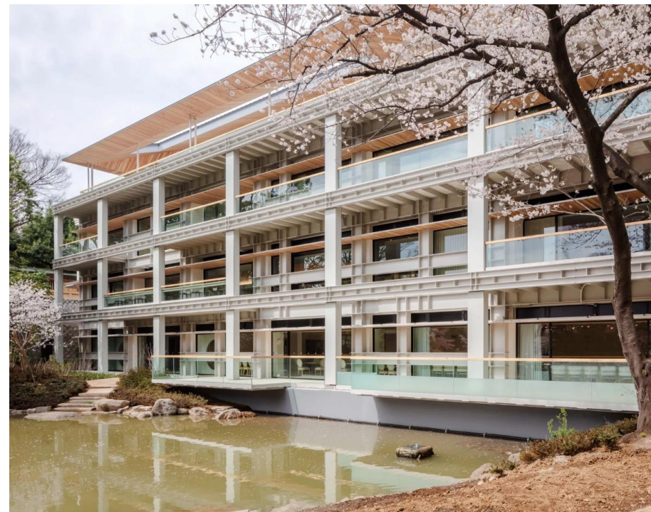
▲改修後の外観
