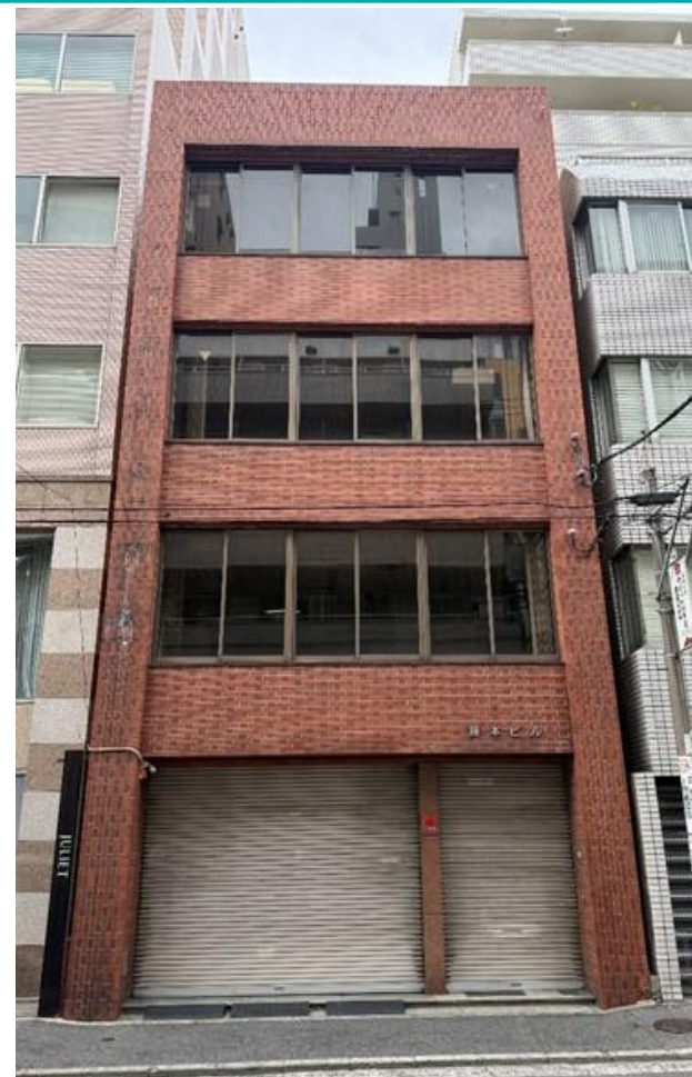
▲改修前の物件の様子
