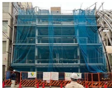
施工中（鉄骨造増築）
