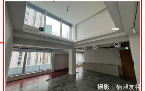
既存部 既存外気壁ラインと新規サッシが重なる（5階）
