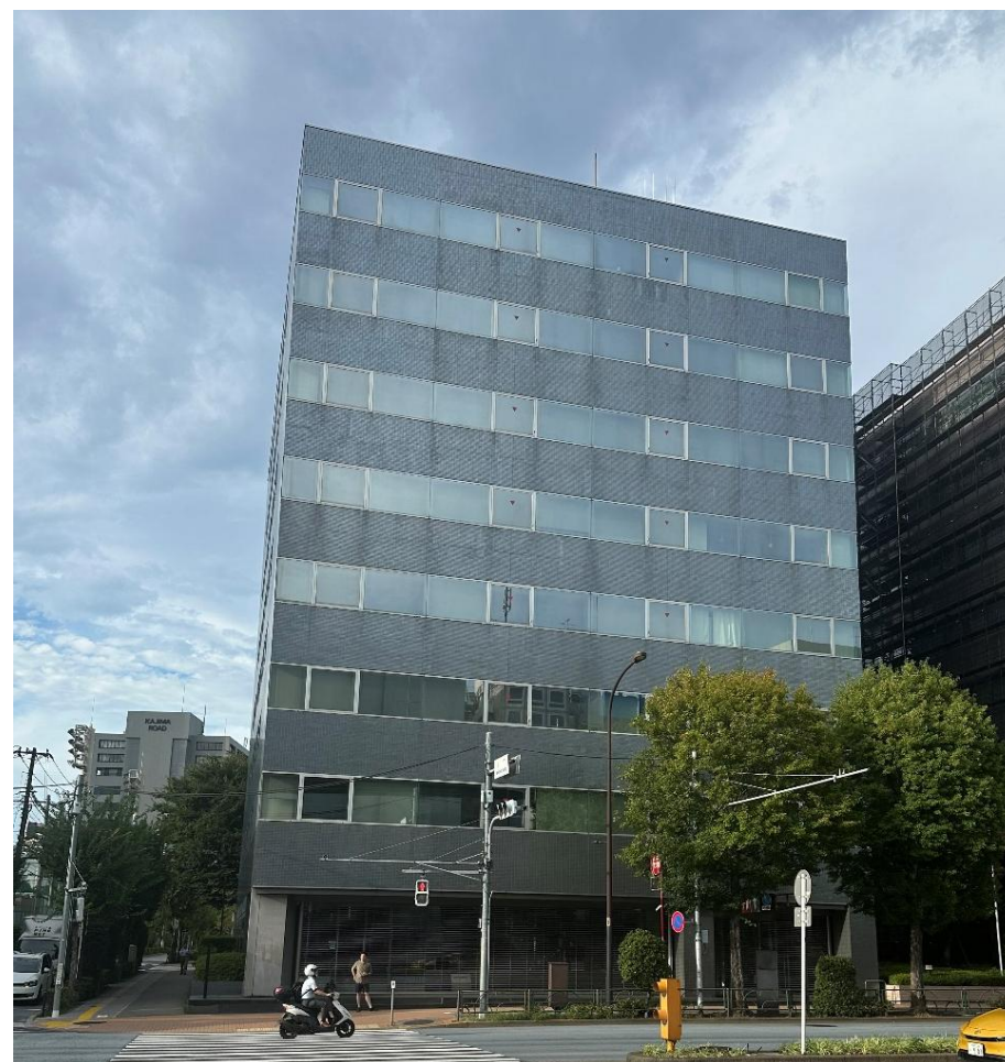
▲改修前の物件の様子
