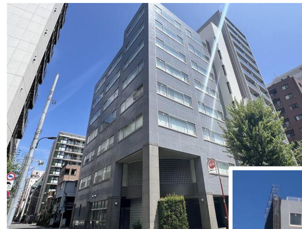
▲▶改修前の物件の外観
