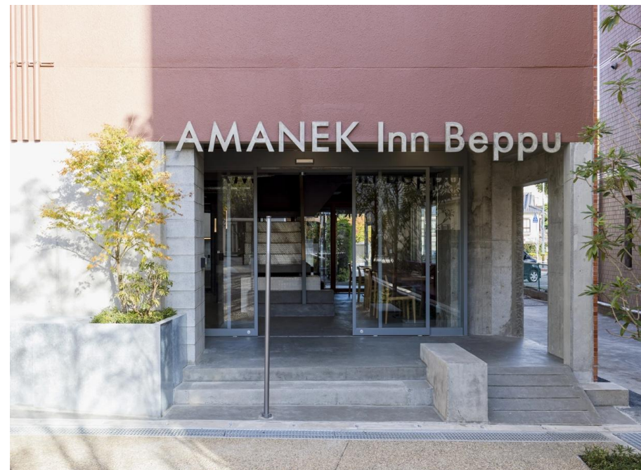
▲改修後の外観
