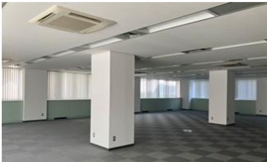
▲改修前のオフィス基準階内の様子
