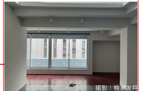
既存部 既存外気壁ラインと新規サッシが重なる（5階）
