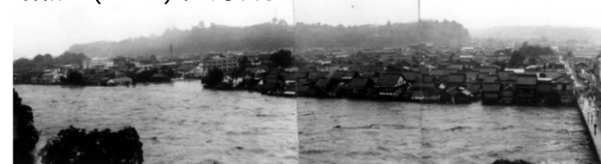
人吉大橋付近の浸水状況
