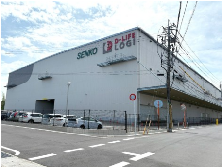
佐賀県鳥栖市（大型物流施設）
