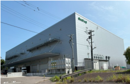
佐賀県基山町（大型物流施設）
