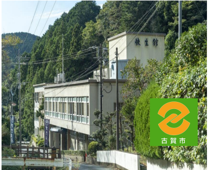
快生館 (古賀市)
