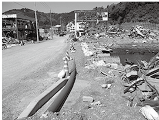
写真9-1-1 被災直後の仮設配管（宮城県女川町）
