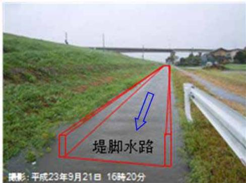
写真-2 利根川堤防の堤脚水路
