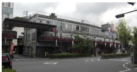
防火建築帯 (岐阜県大垣市)
