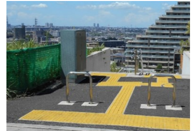
歩行者専用道への地上機器の設置
