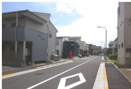
区画道路における無電柱化
