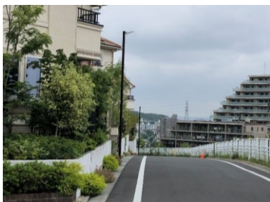
区画道路における無電柱化
