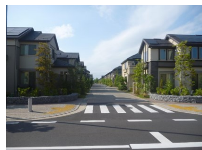
区画道路における無電柱化
