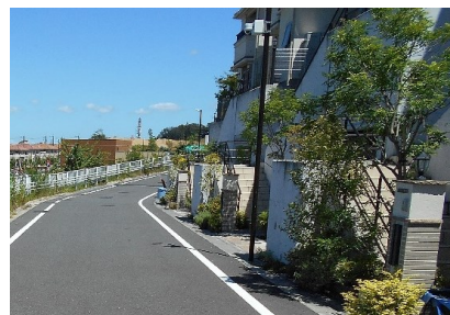
区画道路における無電柱化
