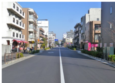
幹線道路における無電柱化
