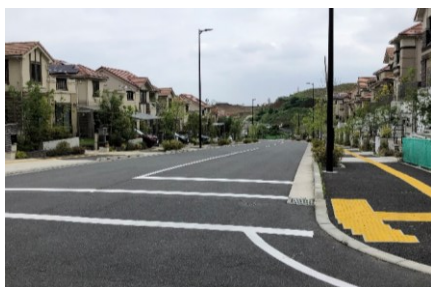
幹線道路における無電柱化
