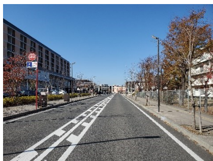
幹線道路における無電柱化
