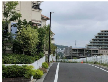
区画道路における無電柱化
