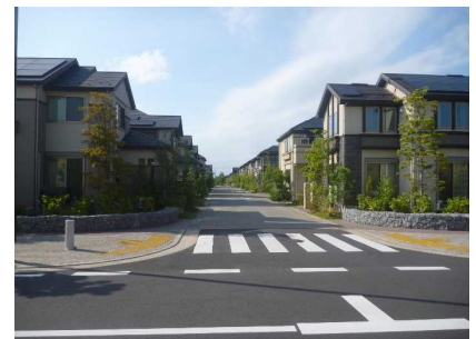
区画道路における無電柱化
