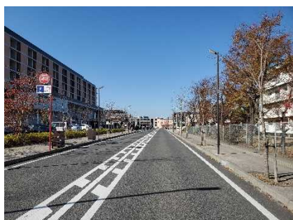
幹線道路における無電柱化
