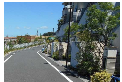
区画道路における無電柱化
