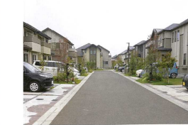
守谷市松並土地区画整理事業 (茨城県守谷市)
