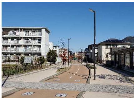
区画道路における無電柱化
