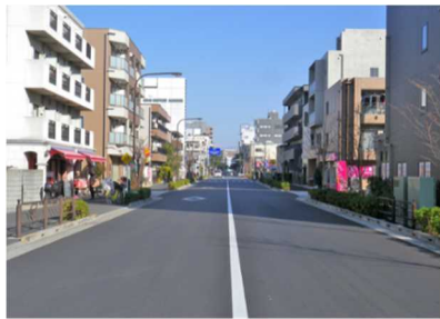
幹線道路における無電柱化
