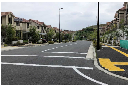
幹線道路における無電柱化
