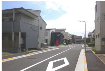
区画道路における無電柱化
