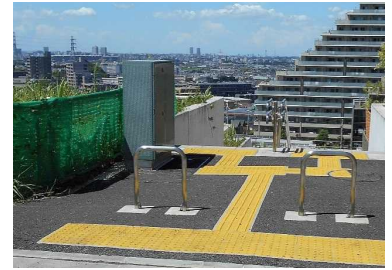
歩行者専用道への地上機器の設置
