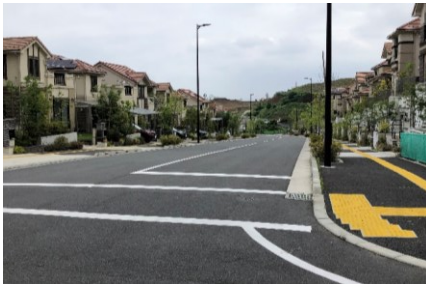
幹線道路における無電柱化
