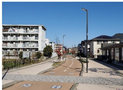
区画道路における無電柱化
