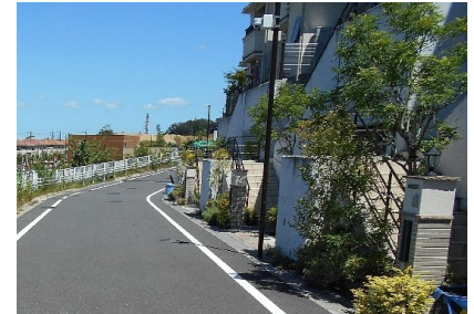
区画道路における無電柱化
