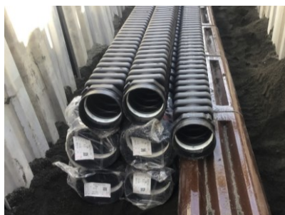
【写真】 港区泰明町地区の施工の様子 (骨格道路歩道部に角型 FEP 管を埋設)
