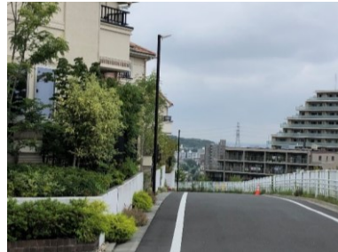
区画道路における無電柱化
