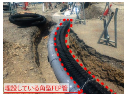
【写真】 多治見駅南地区の様子 (交通広場歩道部に曲げ半径約5mで埋設)
