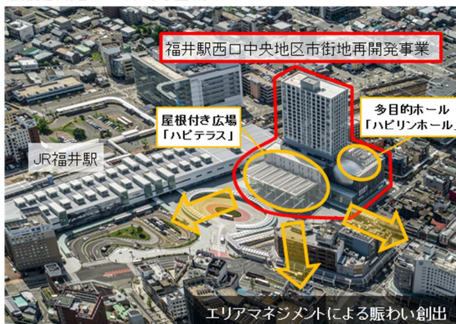
駅前広場との一体的な整備
