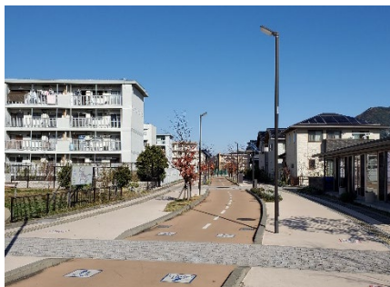
区画道路における無電柱化
