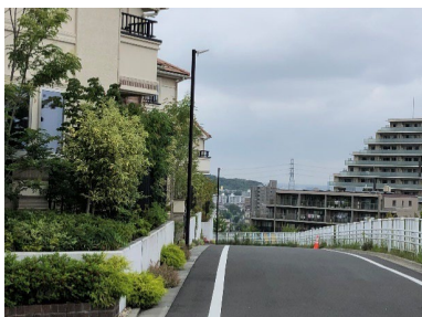
区画道路における無電柱化
