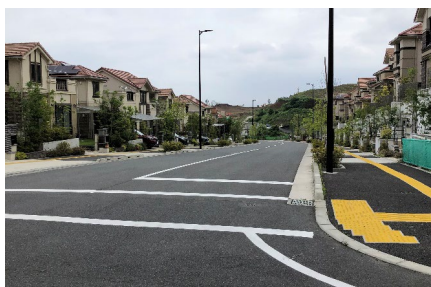
幹線道路における無電柱化
