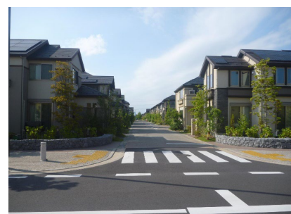
区画道路における無電柱化
