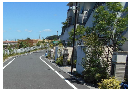
区画道路における無電柱化
