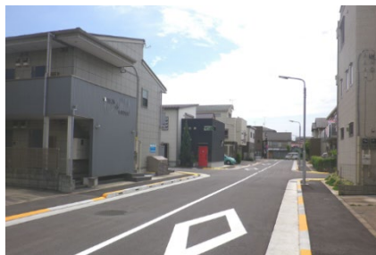
区画道路における無電柱化
