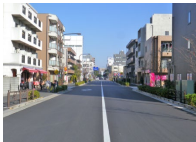
幹線道路における無電柱化
