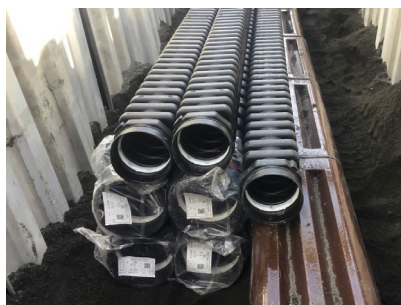
【写真】 港区泰明町地区の施工の様子 (骨格道路歩道部に角型 FEP 管を埋設)
