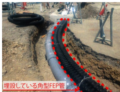
【写真】 多治見駅南地区の様子 (交通広場歩道部に曲げ半径約 5m で埋設)
