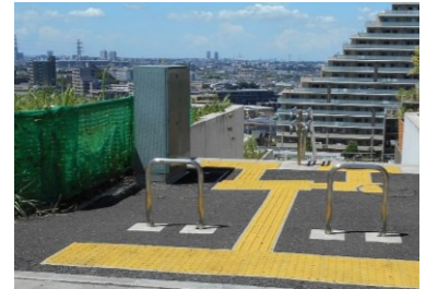
歩行者専用道への地上機器の設置
