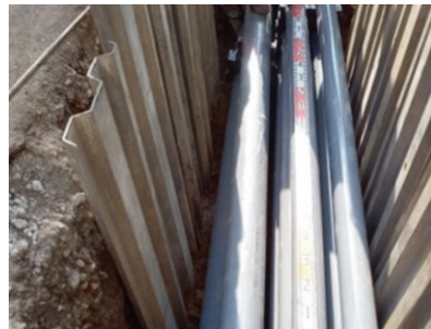
【写真】 西新宿五丁目中央南地区の施工の様子 (電線類を DP : 0.8m で埋設)
