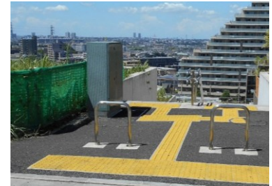
歩行者専用道への地上機器の設置
