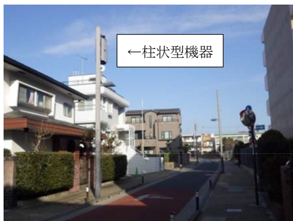
【写真】 柱状型機器の事例(東京都文京区)
