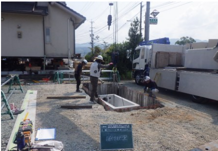
段階的に無電柱化工事をしている様子
