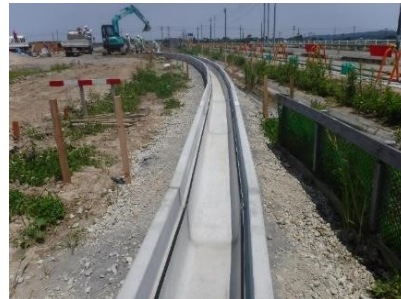
【写真】 ウエルネスタウンみつけの施工の様子 (内径幅 250mm・深さ 200 の小型ボックスを埋設)
