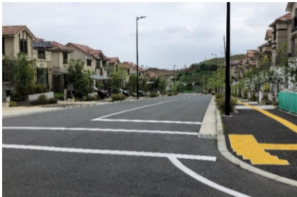
幹線道路における無電柱化
