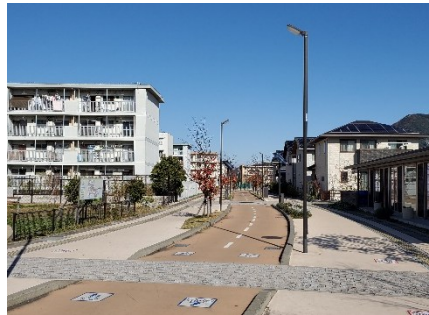
区画道路における無電柱化
