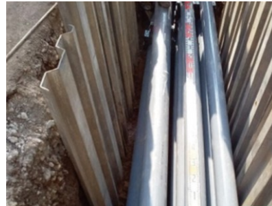
【写真】 西新宿五丁目中央南地区の施工の様子 (電線類を DP : 0.8m で埋設)
