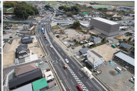
都市計画道路における無電柱化(工事途中)
