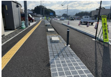
無電柱化工事完了箇所
