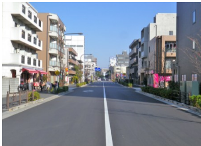
幹線道路における無電柱化
