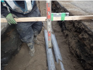
【写真】 新綱島駅周辺地区の施工の様子 (電線類を DP : 0.6m で埋設)
