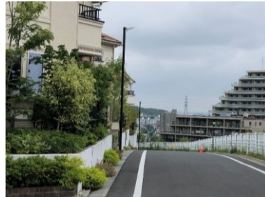
区画道路における無電柱化
