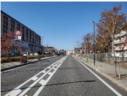
幹線道路における無電柱化
