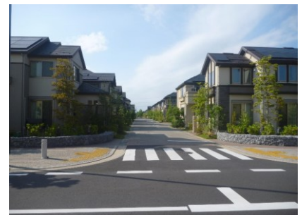
区画道路における無電柱化
