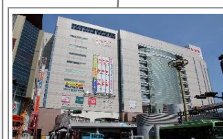
【高松市】高松琴平電気鉄道(株) 『瓦町駅核化プロジェクト事業』 [瓦町FLAG] 認定：H27.10.20
