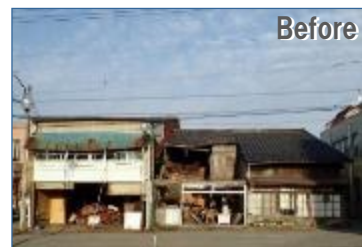
空き家の除却
