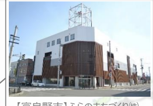
【富良野市】ふらのまちづくり(株) 『フラノ・コンシェルジュ整備事業』 [コンシェルジュフラノ] 認定：H29.3.23
