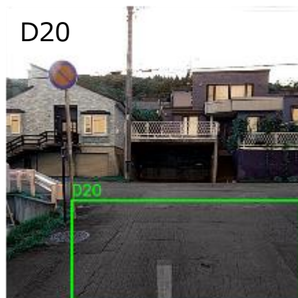
亀甲状ひび割れ
