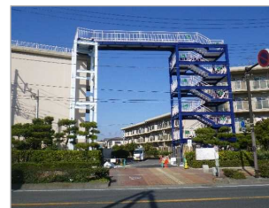
既存施設（市営住宅）へ避難階段設置
