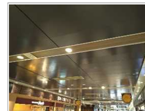
天井板の耐震改修
