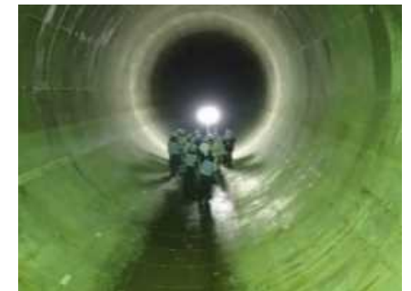
雨水貯留管の整備
