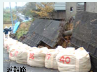
擁壁の防災対策
