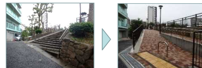
避難しやすいように階段をスロープに改修
