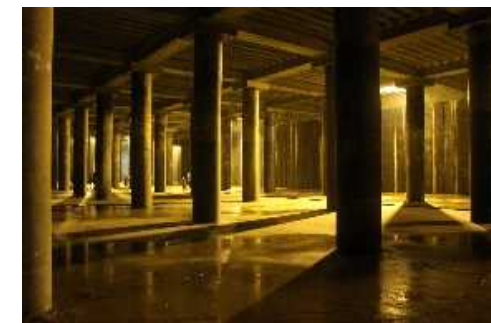
貯留施設の整備
