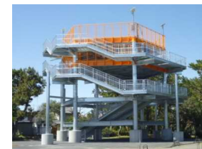
津波避難タワー
