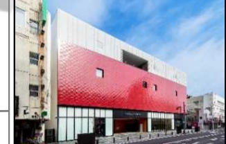
【八戸市】(株)江陽閣 『六日町地区複合ビル整備事業』 [ガーデンテラス] 認定：H27.5.12
