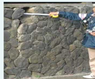
擁壁の危険度調査
