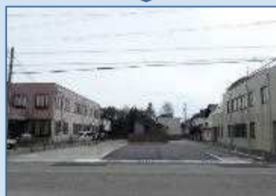
居住環境の整備改善のため、空き家を除却し防災空地を整備
