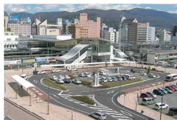
交通結節点整備
