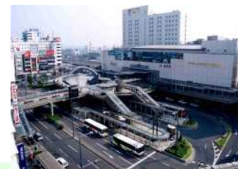
ペDESTリアンデッキ
