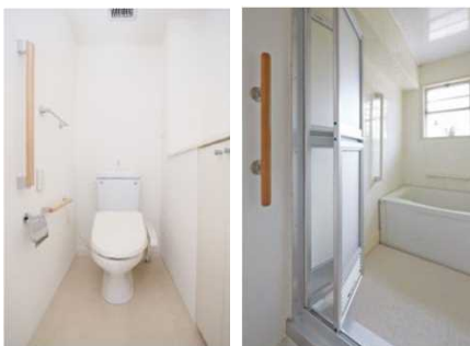
住戸内への手すりの設置
