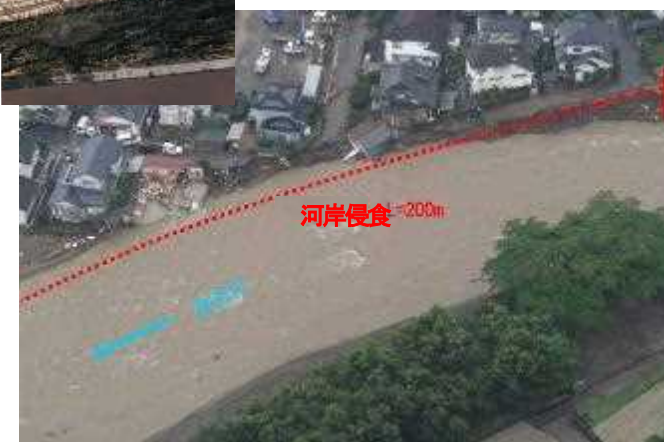
河岸侵食に伴う家屋倒壊等
