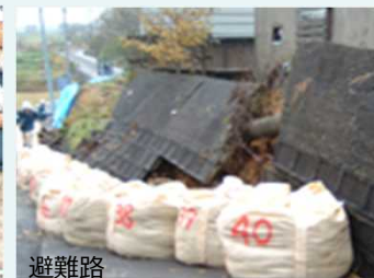
擁壁の防災対策
