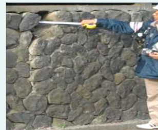
擁壁の危険度調査
