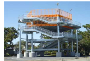
津波避難タワー
