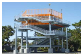
避難タワーの整備
