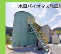
木質バイオマス発電所
