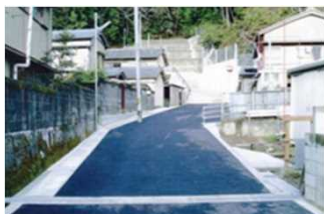
避難路の整備
