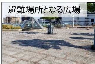
屋上の広場は浸水時に一時避難場所として活用
