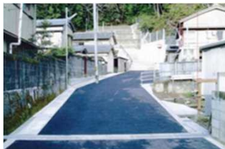
避難路の整備
