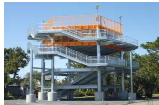
避難タワーの整備
