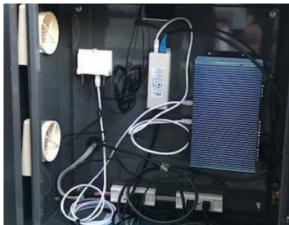
▲カメラの付帯設備
