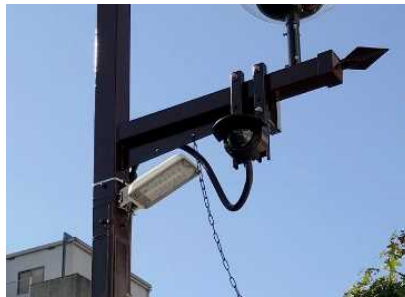
▲カメラ設置の状況
